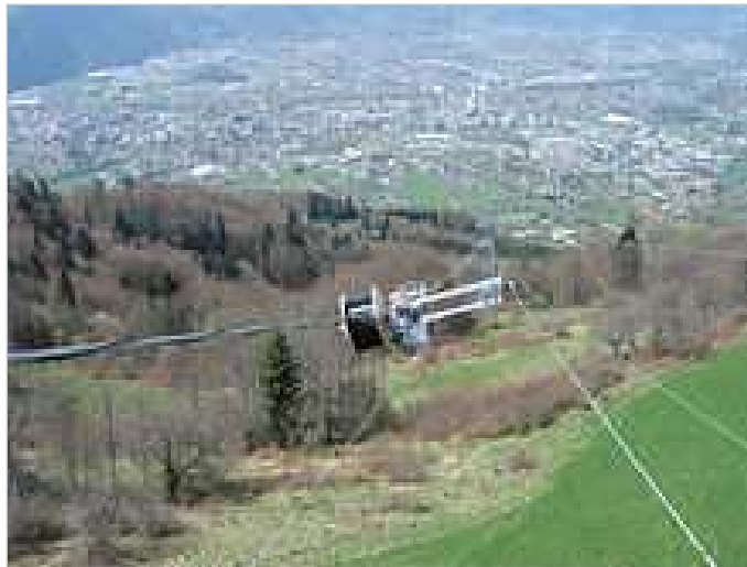
Slika 4. Instalacija SkyWrap optičkog kabla
